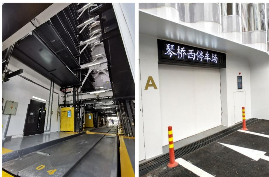
图 4 琴桥西机械式立体停车库内部设备及出入口
